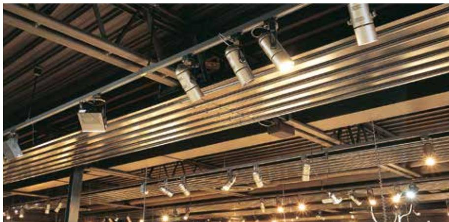
Die umfangreiche Ausleuchtung des Showrooms führte zu unangenehm hohen Wärmelasten. Aus diesem Grund wurde die konventionelle Lüftungsanlage mit einer separaten Kälteanlage mit Kühldecke ergänzt.
