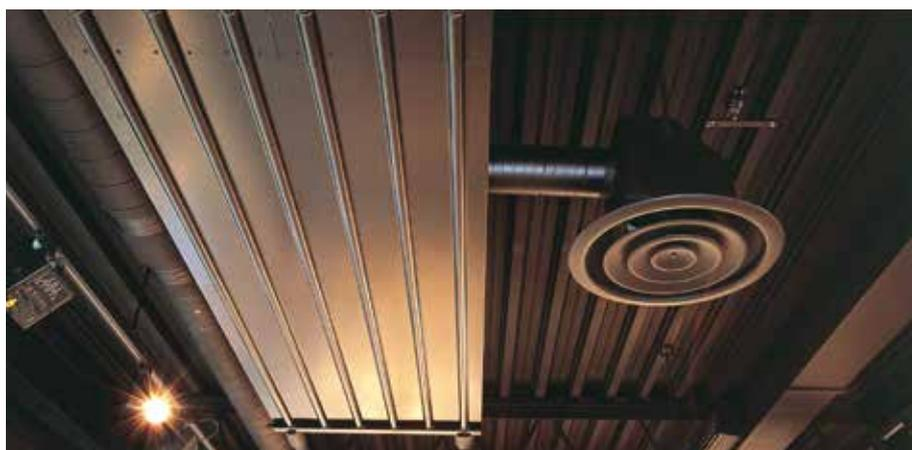
Die Aufhängung der Deckenstrahlplatten erfolgte waagrecht an die vorhandene Trapezdecke mit Ketten und Spanschlössern. Der laufende Betrieb der Showrooms wurde während der Montage nicht gestört.
